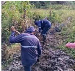
En el mes de Agosto se dará inicio a los trabajos de reposición a un tramo de red por más de 300 metros en el sector cercano a IMUSA, en la Autopista. Se trata de una tubería que presenta continuas averías debido a su vejez y deterioro. Será reemplazada por tubería de polietileno para la cual, cabe recordar, se adquirieron los equipos de termofusión el mes anterior.
