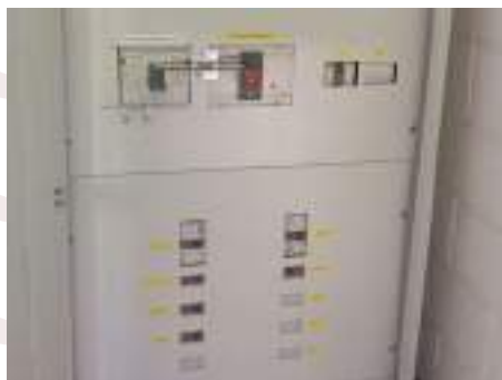
Sistema manual de transferencia eléctrica de la planta de 165 KVa.
