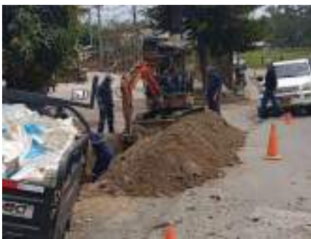
Activación de los cruces pendientes de empate para unión de redes instaladas en el sector de Galicia, algunos en ejecución al momento.
