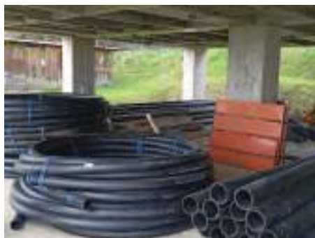
Adquisición de tubería en polietileno de diversos diámetros para redes principales y conexiones de circuitos faltantes de cruces.
